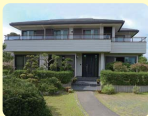
たくさんの開口部を持つK邸。南向きファサードだけで8つの窓がある
