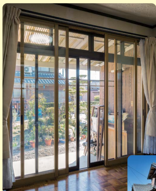
リビングの掃き出し窓には4枚引きの内窓を設置。自由に動き、拭き掃除もしやすい。窓枠は閉めた際に外窓の枠とぴったり重なるので視覚的にもうるさくない
